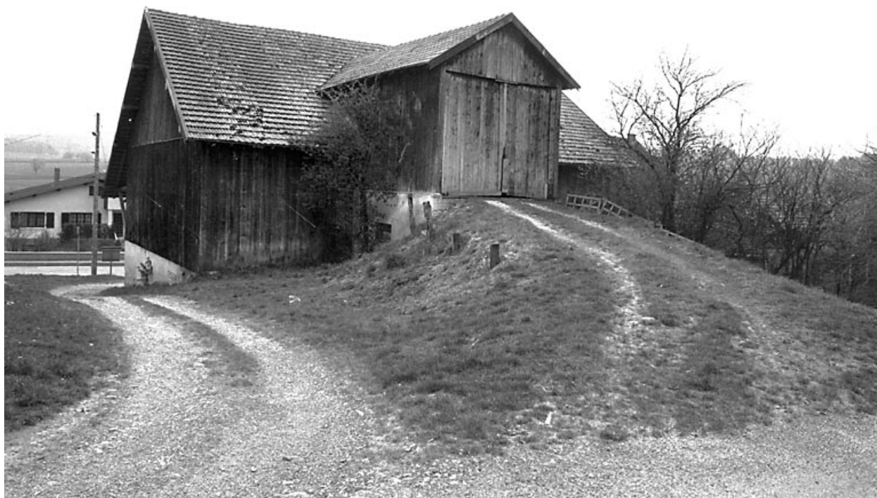
Partie agricole : façade postérieure.
