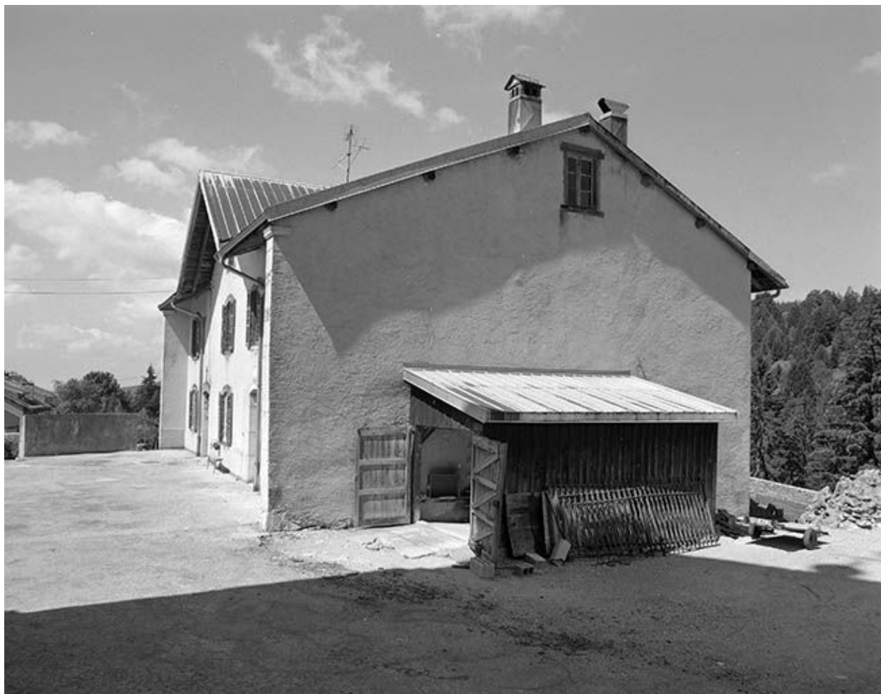
Façade antérieure et face droite.
