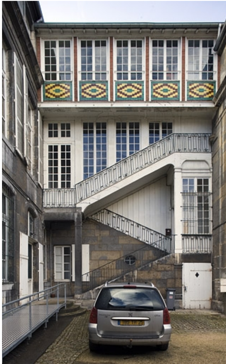
Vue d'ensemble de l'escalier à cage ouverte, de face.
