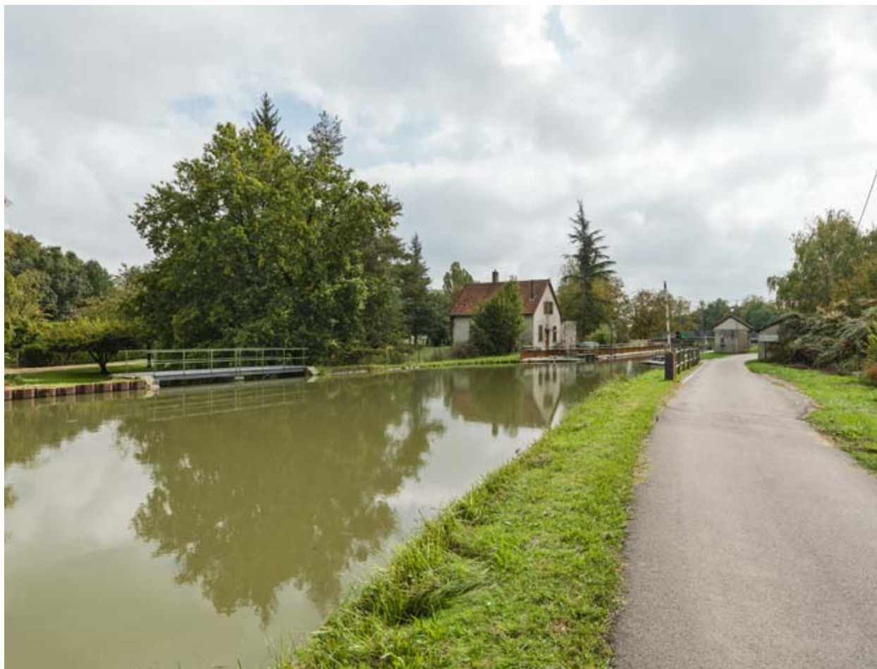
Vue d'ensemble du site d'écluse.
