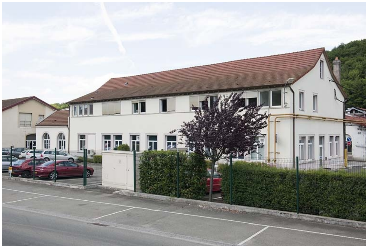
Façade ouest du bureau d'études.
