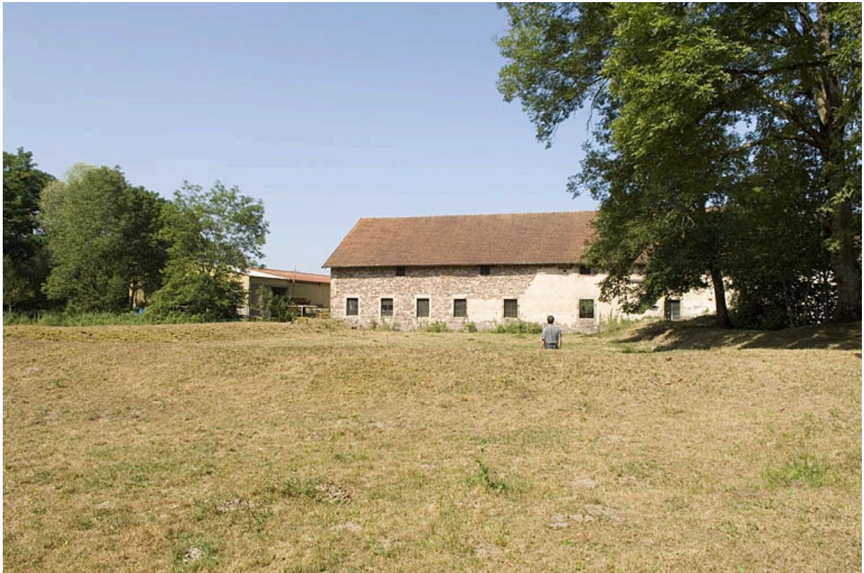
Façade postérieure de la salle des tables et du séchoir. Au premier plan : fosse à pulpe.
