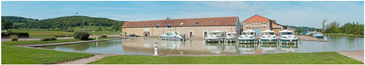
Vue du bassin secondaire rive gauche.
