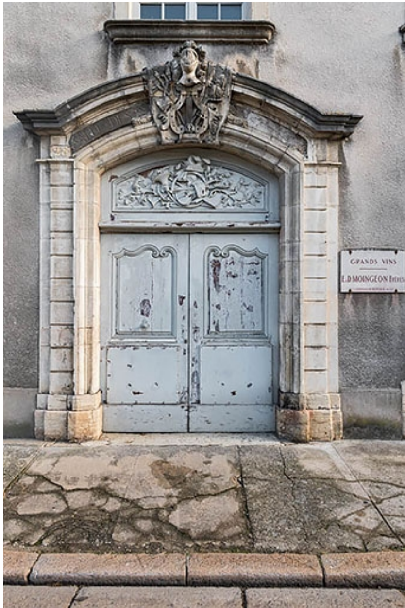
Façade antérieure : portail.
