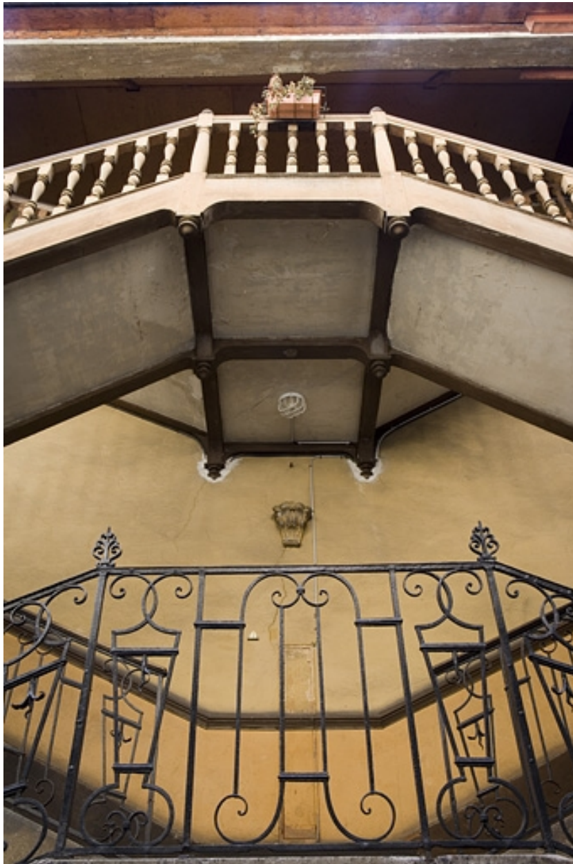
Détail de la partie centrale de l'escalier à cage ouverte sur cour, de face.
