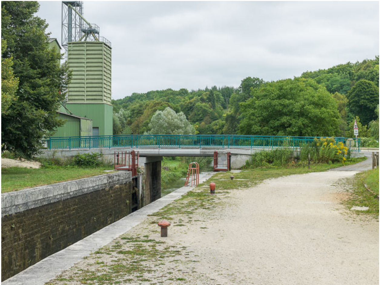
Vue d'ensemble du pont.
