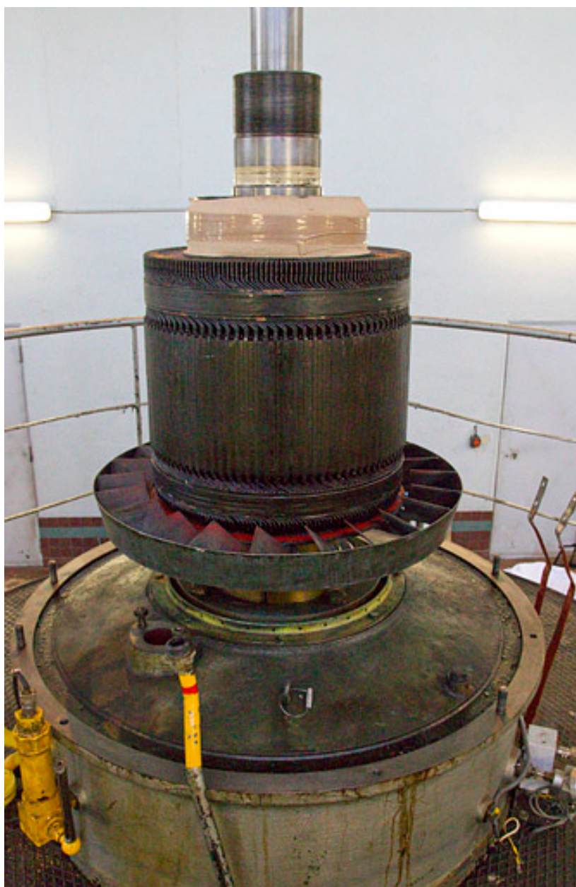
Groupe n° 2 : excitatrice partiellement démontée.
