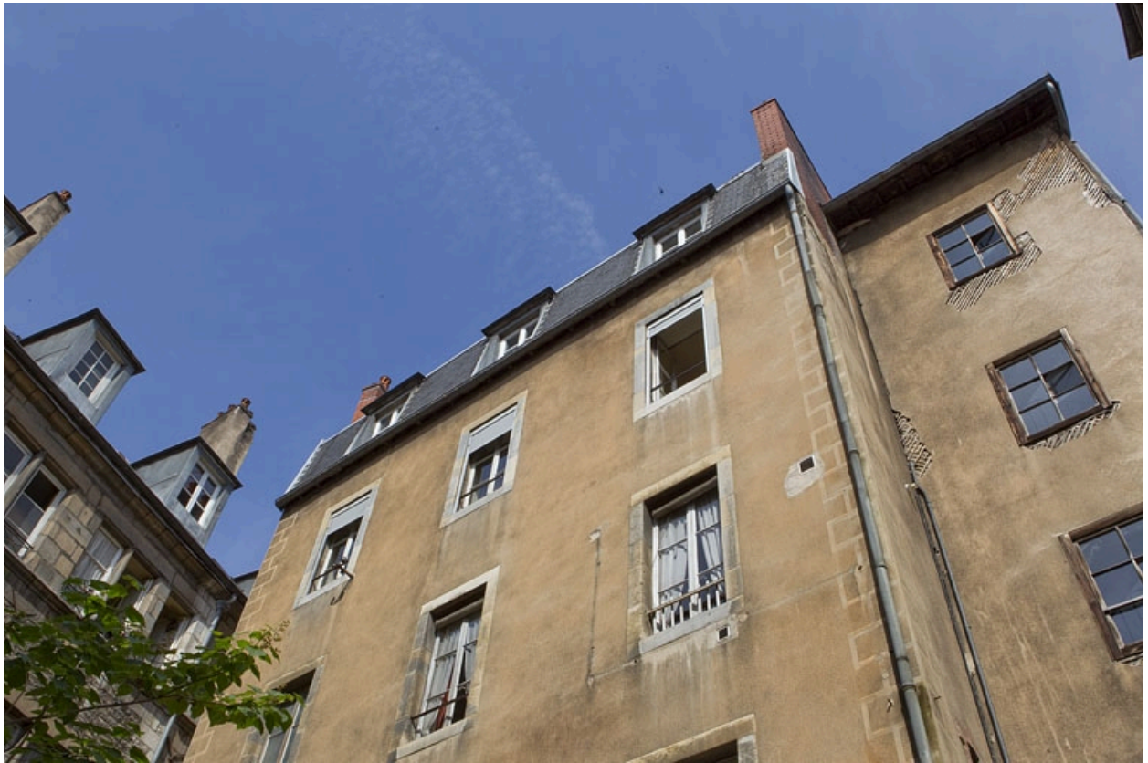
Vue de l'aile gauche de l'immeuble de trois quarts droit.
