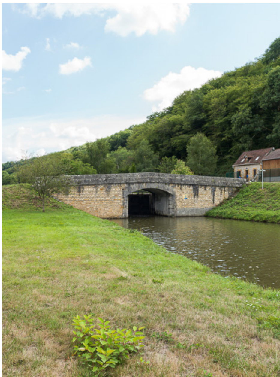
Vue d'ensemble du pont.
