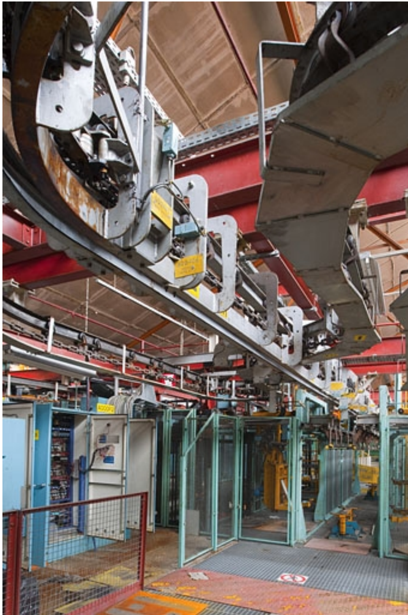
Atelier de montage désaffecté (6). Détail d'un carrousel.
