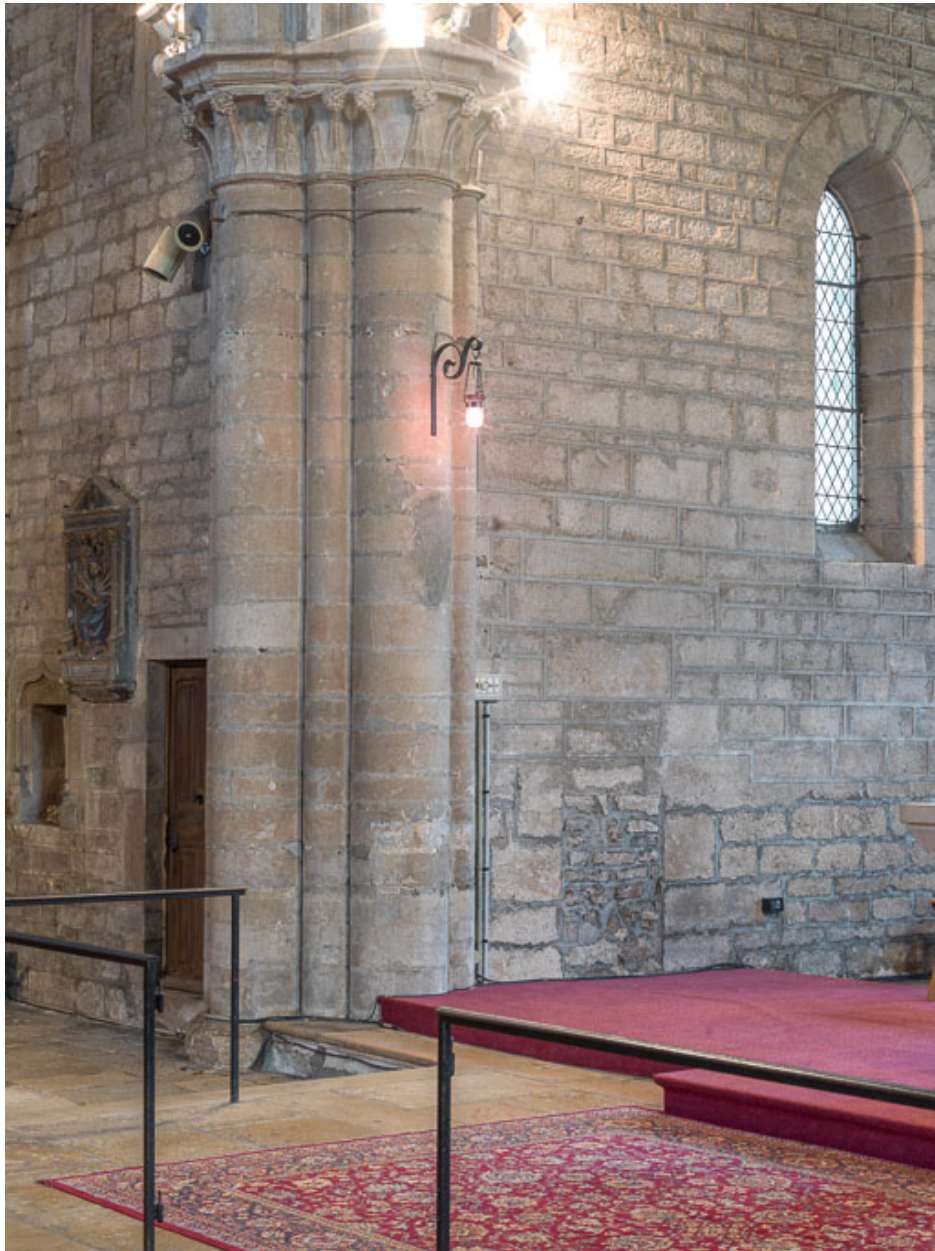
Vue d'un pilier de la croisée.
