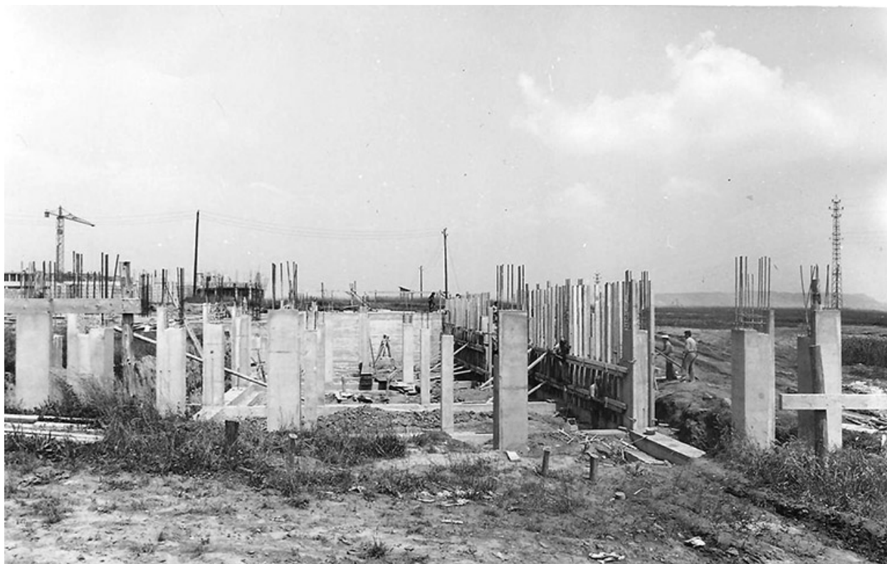
Vue du chantier de construction.
