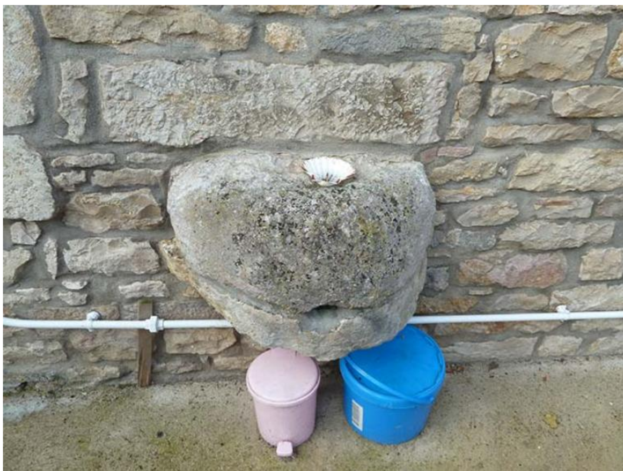
"Goulotte" d'évacuation de l'évier intérieur
