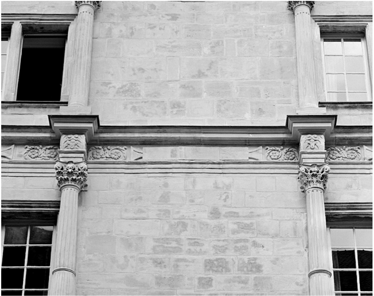
Façade sur la place, deuxième étage, détail de l'ordre corinthien de la travée centrale.
