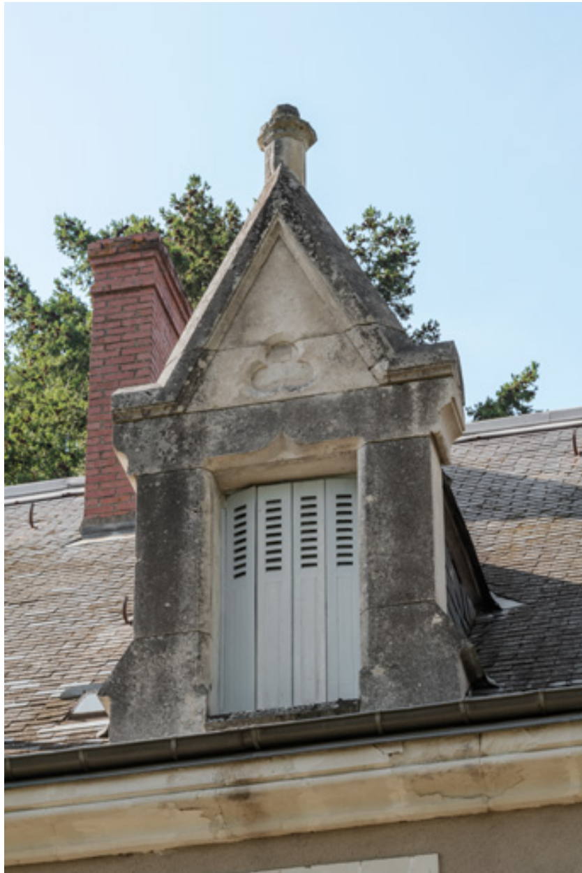
Lucarne centrale du versant sud-est de la toiture.
