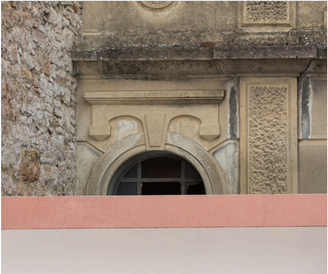
Façade antérieure : décor surmontant une fenêtre.
