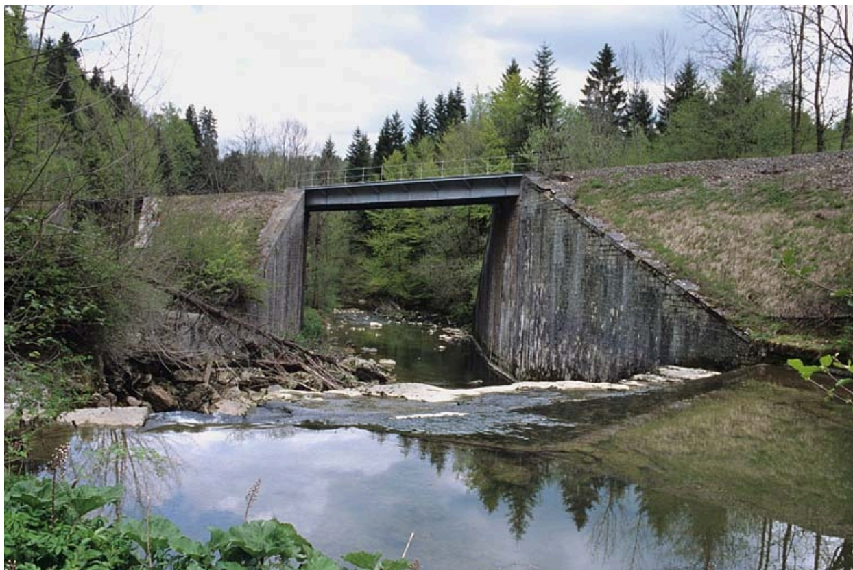
Pont sur la Lemme : vue d'ensemble, côté La Cluse.
