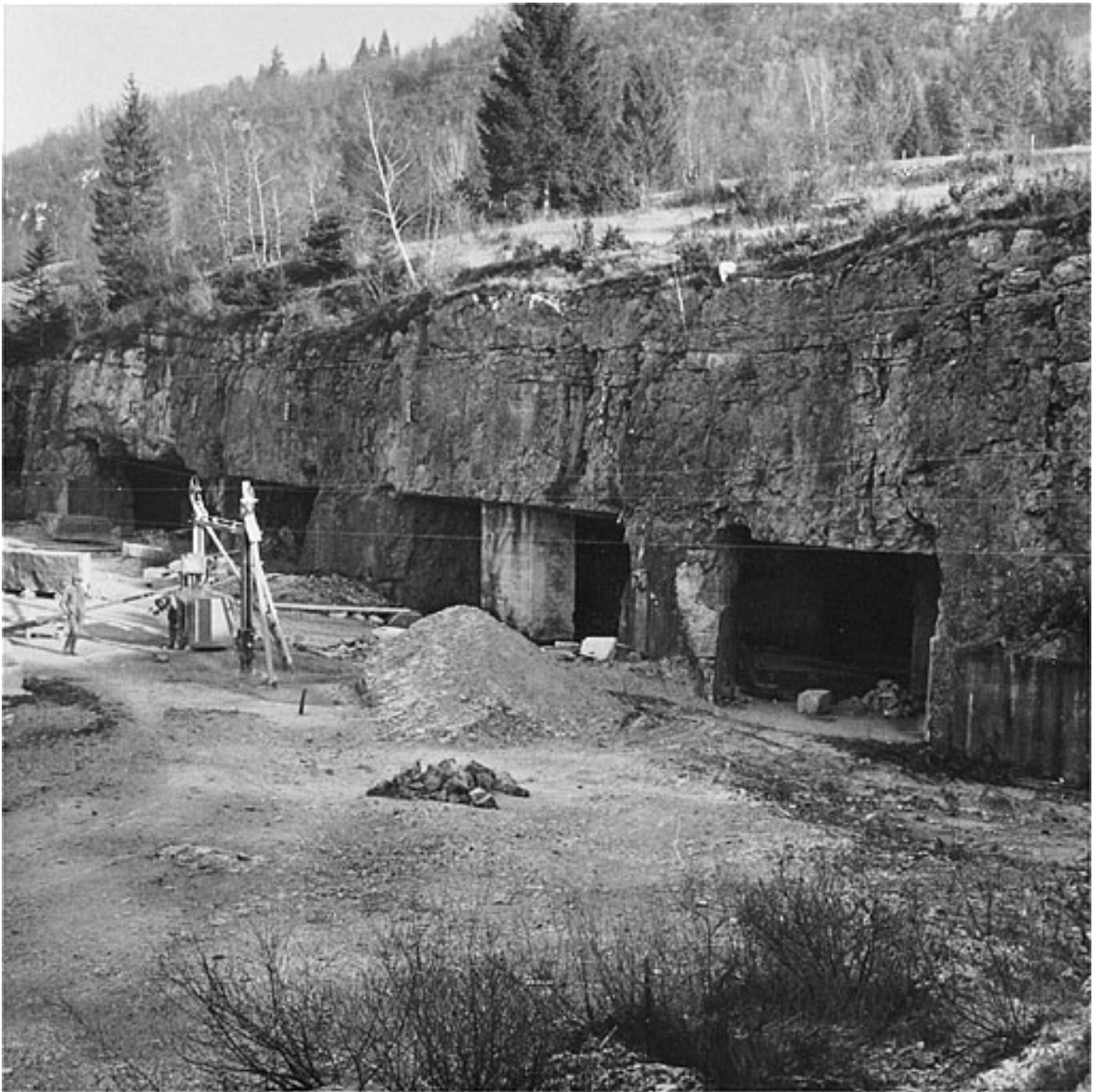
Chantier et entrées de la carrière souterraine.
