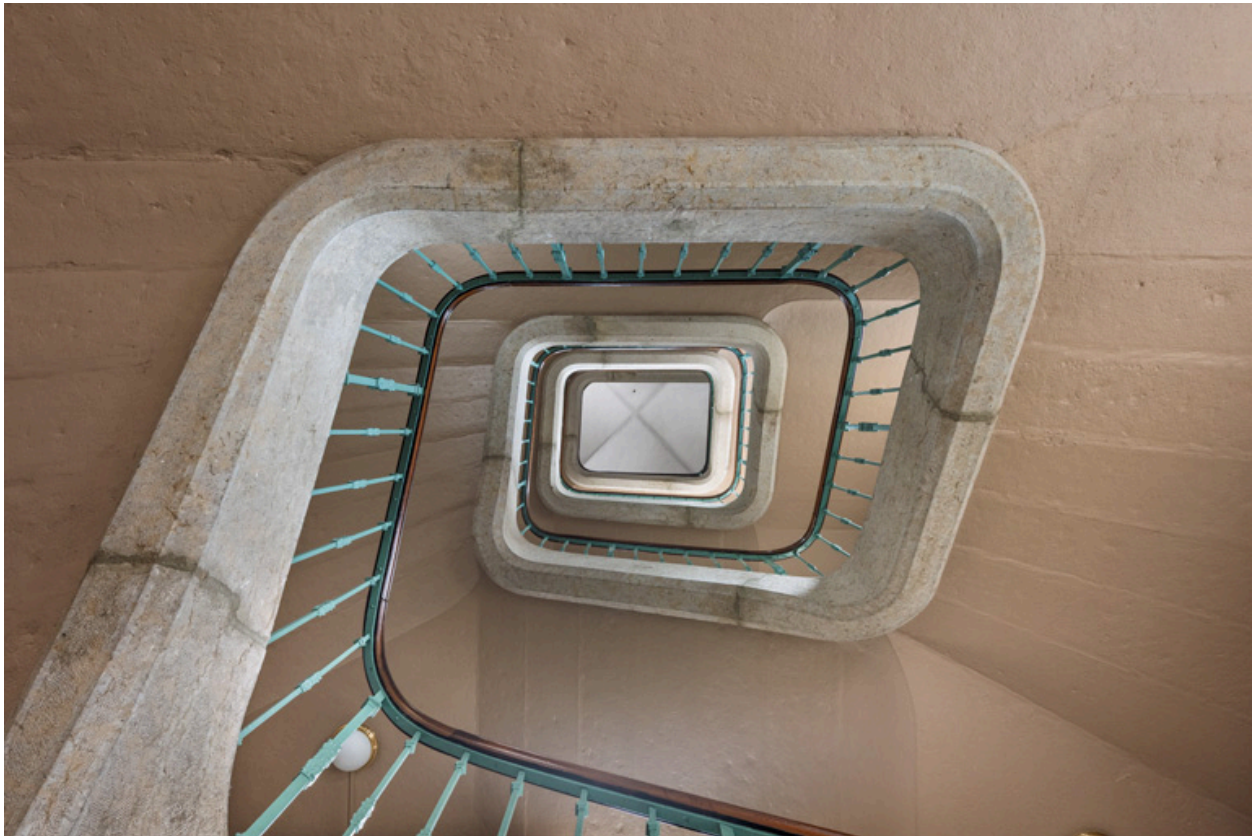
Escalier côté cour, vu en contre-plongée.
