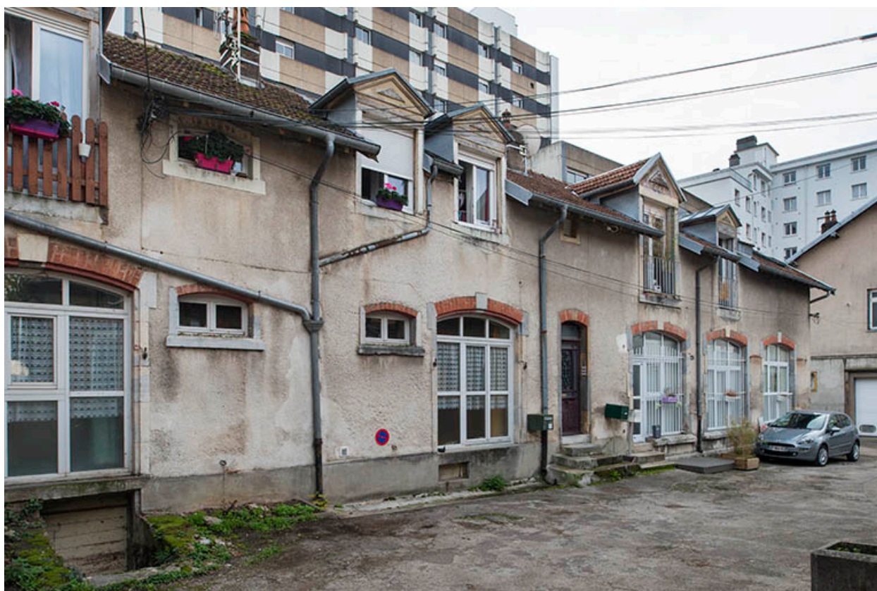
Atelier de fabrication. Façade sur cour.
