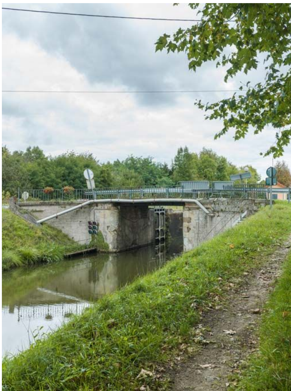
Vue d'ensemble du pont.
