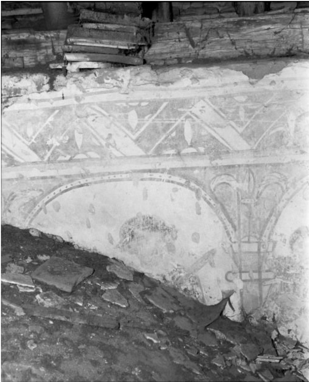
Comble de la nef, mur droit, 3e-4e travées : juin
