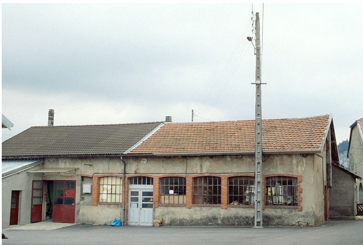
Façade antérieure du second bâtiment.
