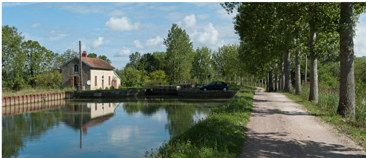
Vue du site d'écluse depuis l'amont.
