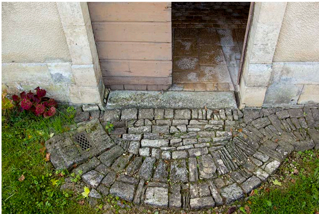
Ecurie, façade nord-est : le pavement devant la porte.
