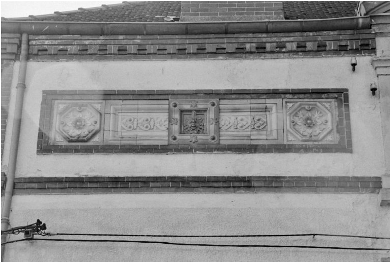
Détail de la façade est : panneaux de céramique (provenance indéterminée).
