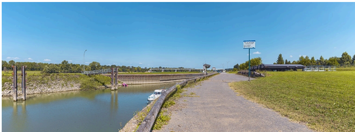
Le site d'écluse vu d'aval.
