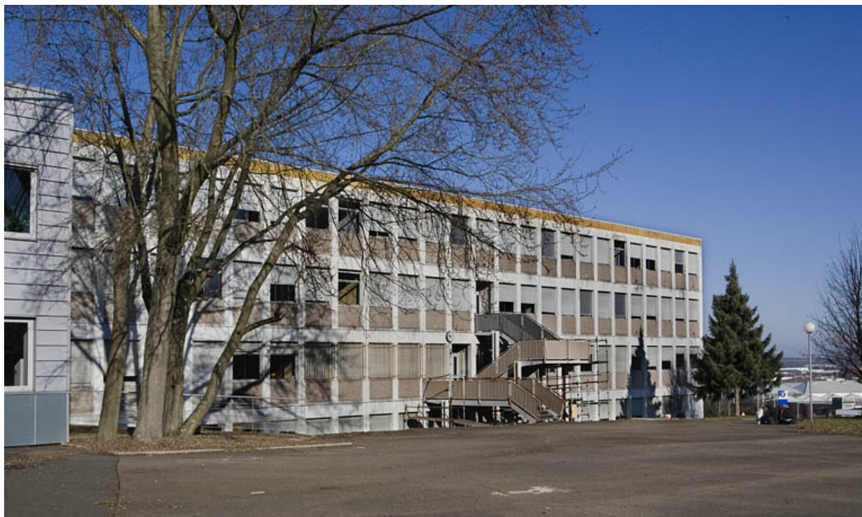
Bâtiment C. Vue de la façade antérieure.
