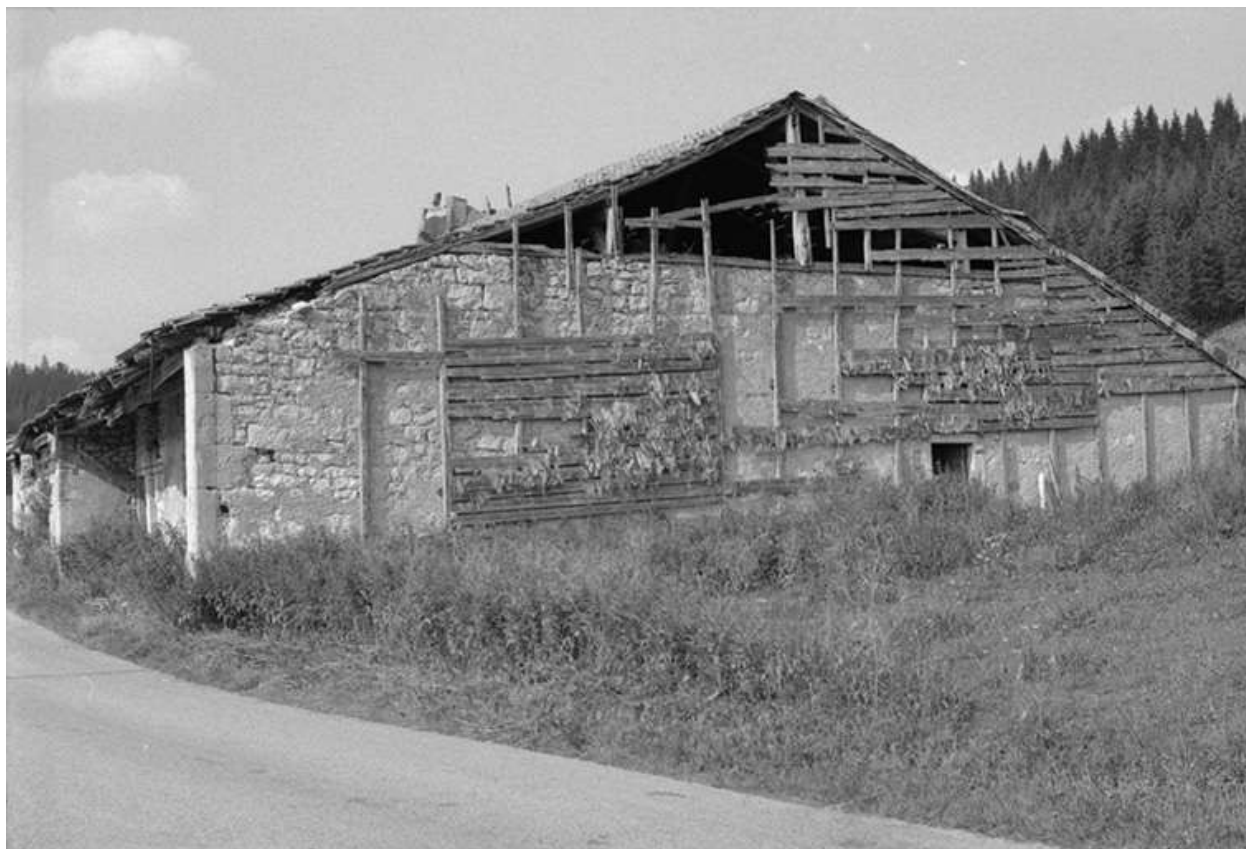
Façade latérale droite.
