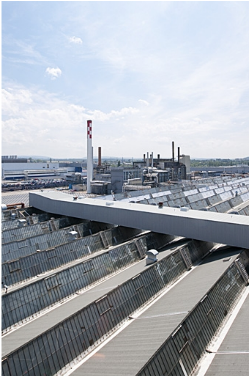
Vue d'ensemble depuis l'est : atelier de ferrage et centrale thermique.
