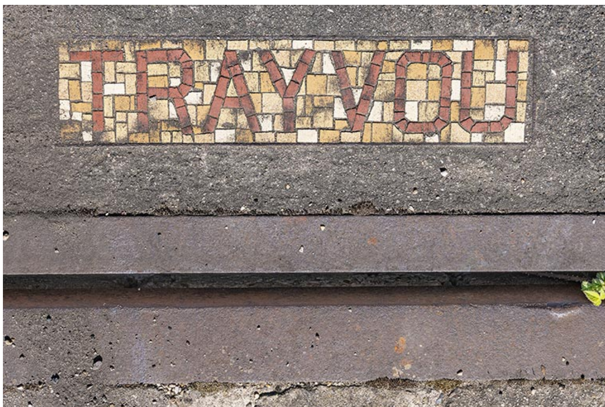
Pont-bascule : détail de la signature de l'entreprise Trayvou.
