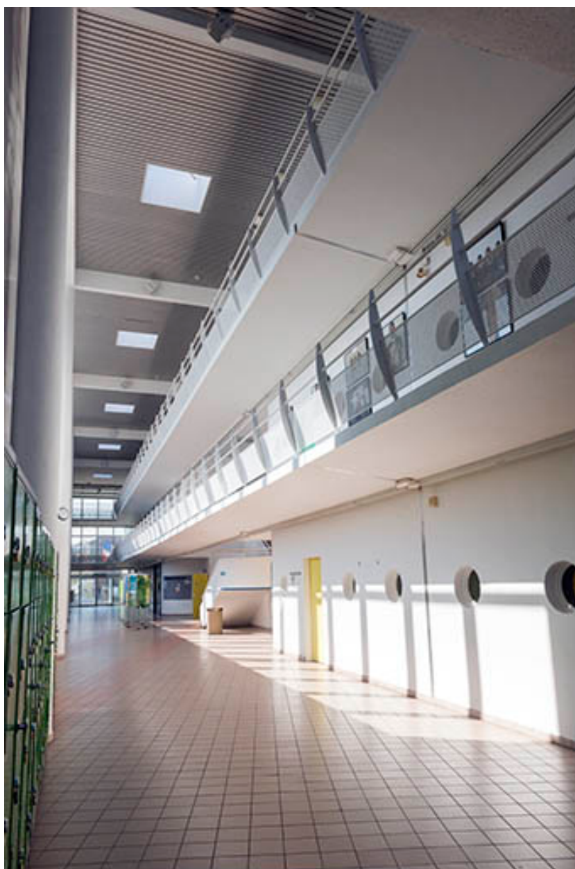
Détails des coursives de la rue intérieure.
