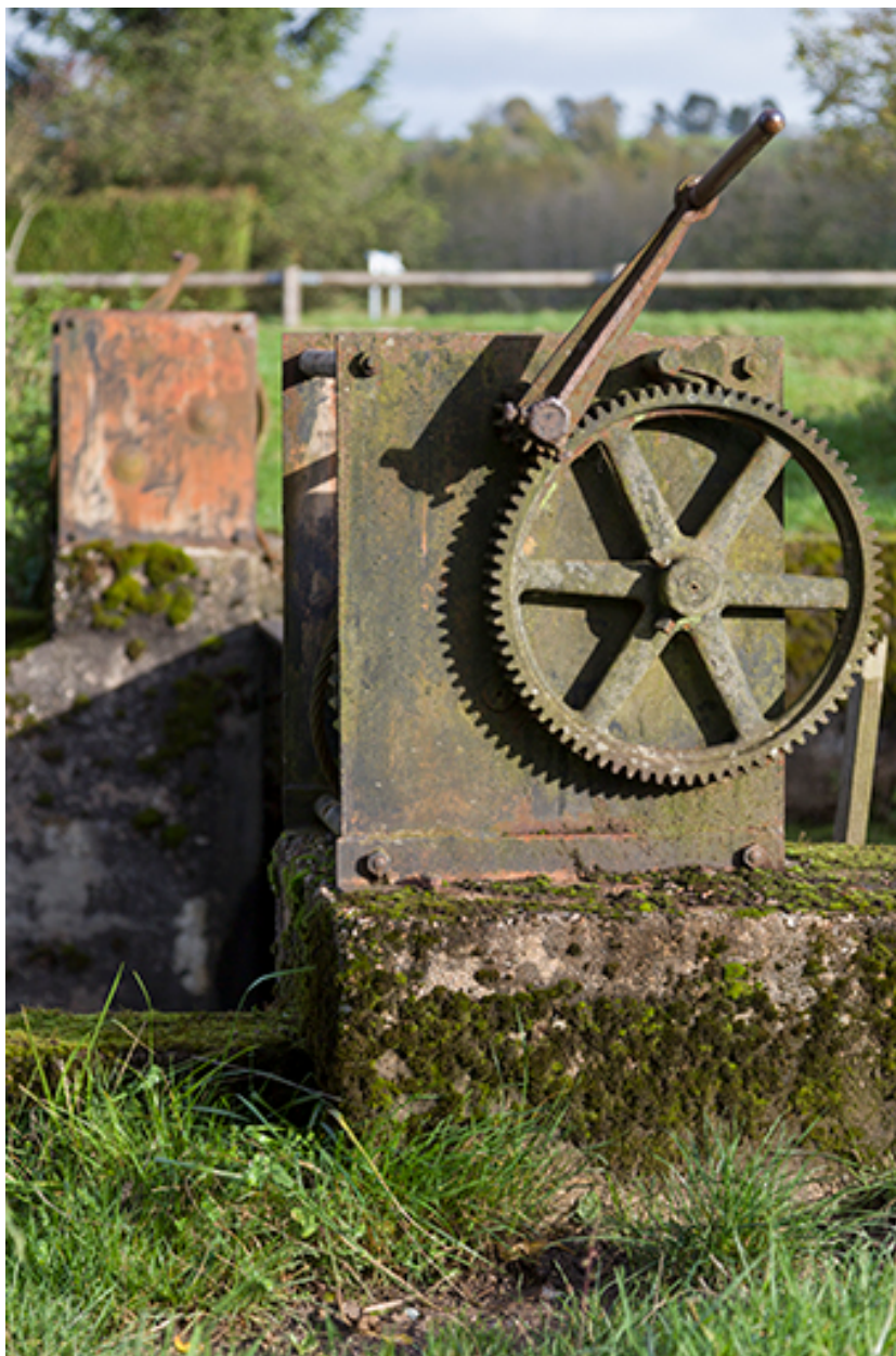
Mécanisme manuel pour ouvrir les portes de l'écluse.
