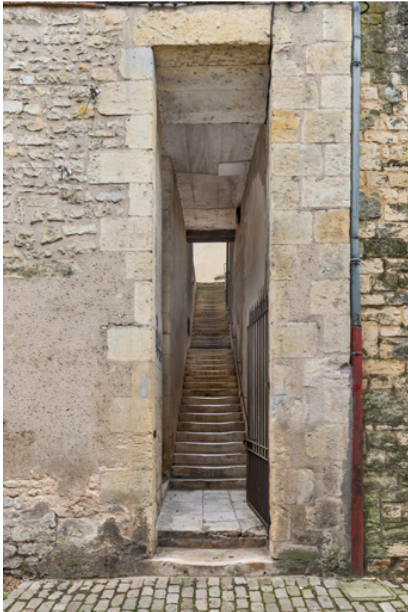
Façade postérieure : escalier reliant la rue des Ouches à l'esplanade du château.
