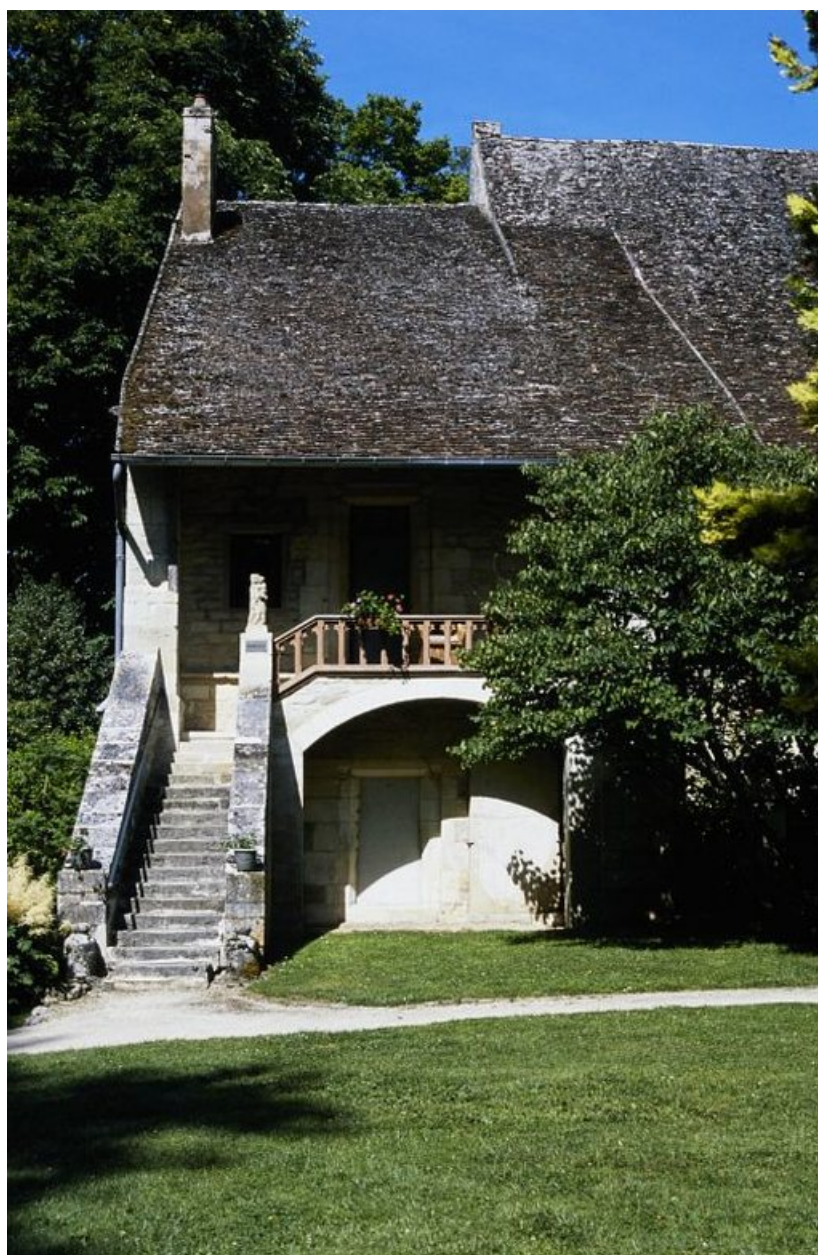
Extrémité nord de l'aile orientale.
