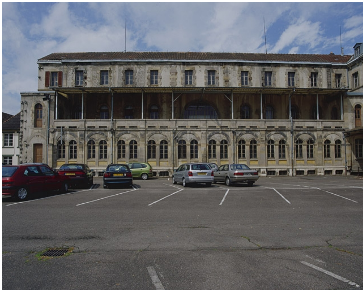
Façade postérieure de l'ancien couvent (actuellement bureaux).
