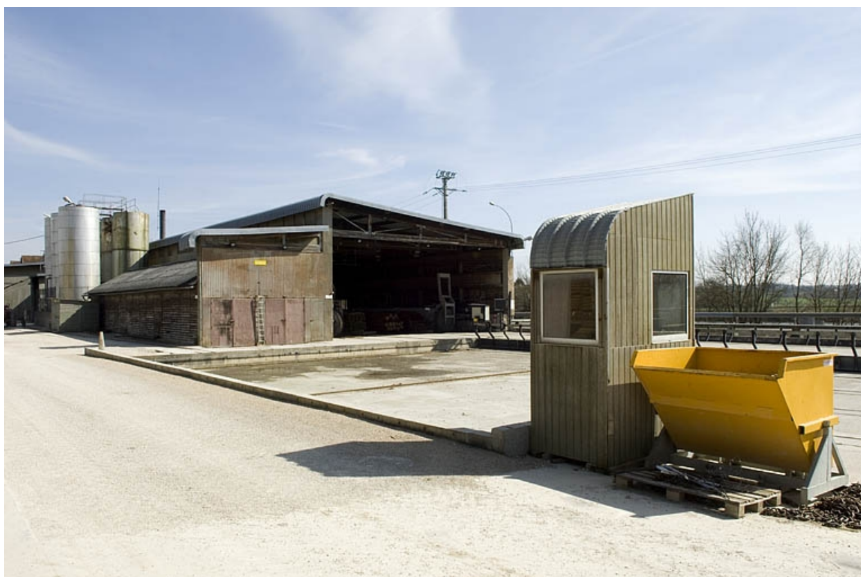
Atelier de fabrication depuis le nord-ouest.
