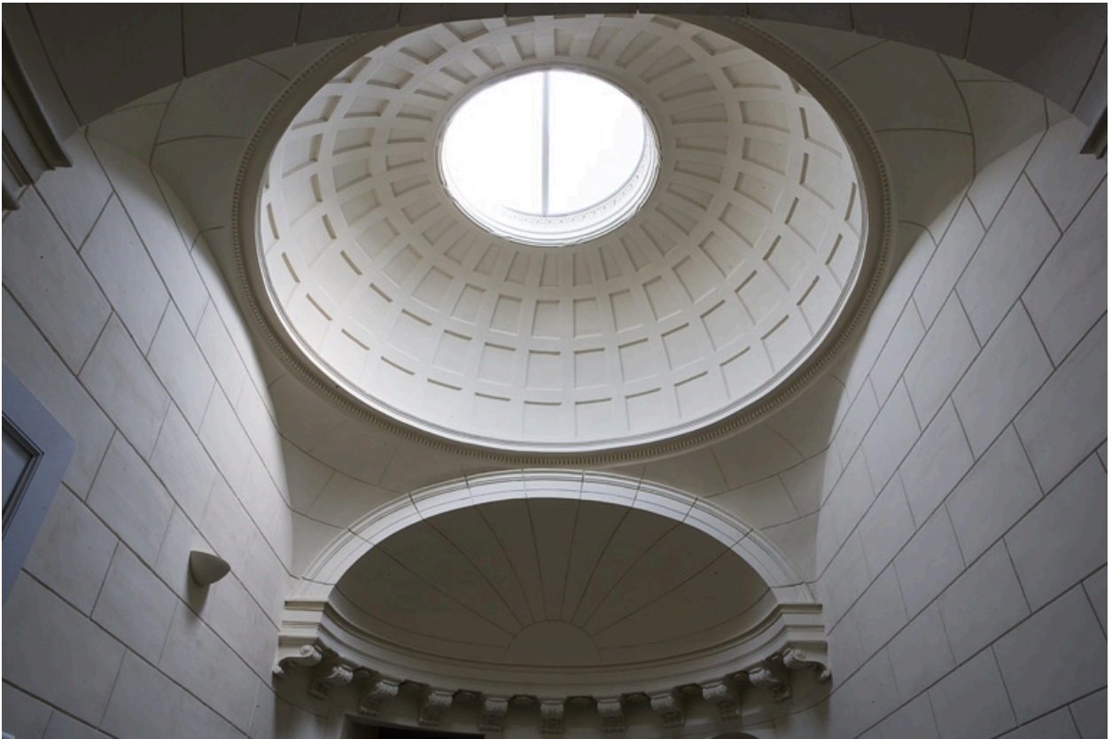
Couvrement de l'escalier : détail de la coupole et d'une demi-coupole.
