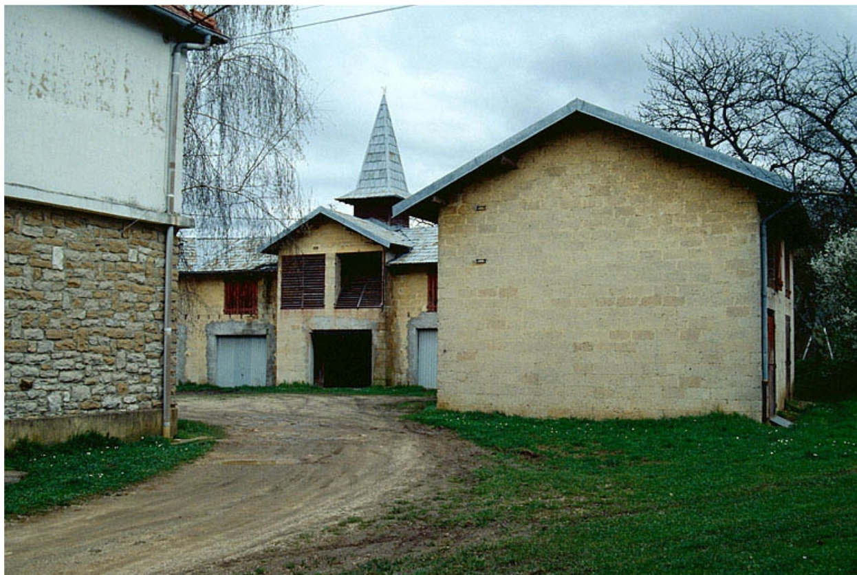
Remise d'automobile et bûcher (F) : entrée.
