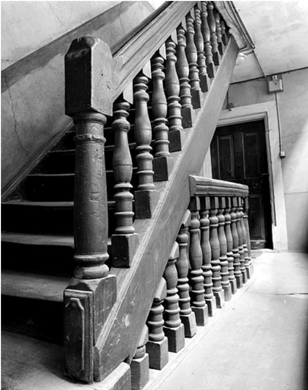
Escalier vu au niveau du premier étage.
