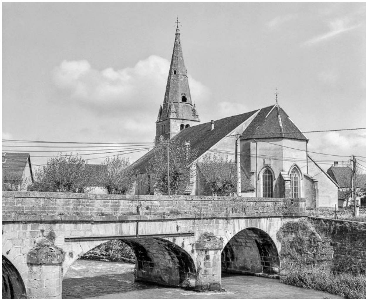
Façade latérale sud et abside.
