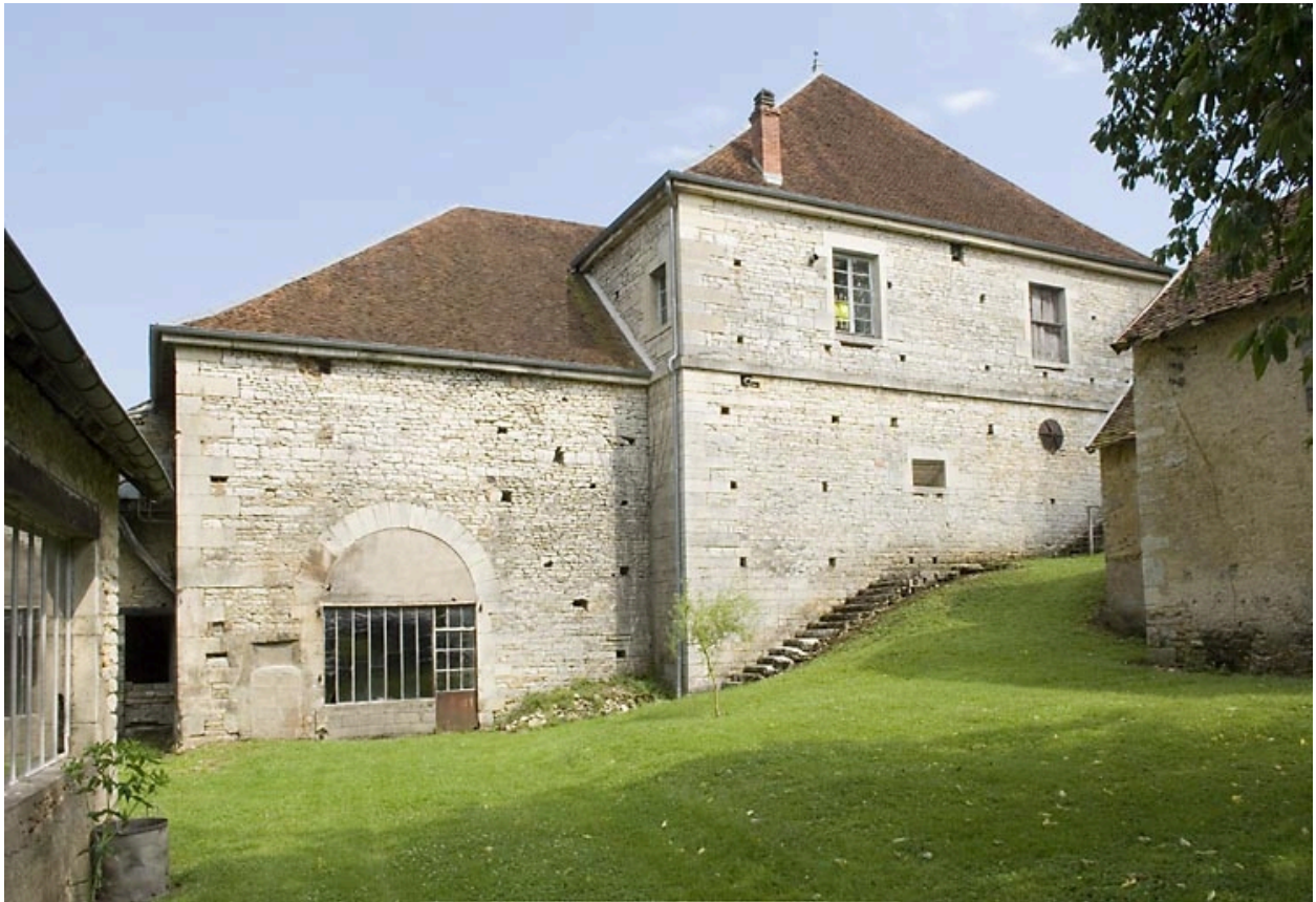
Le haut fourneau vu depuis l'ouest.
