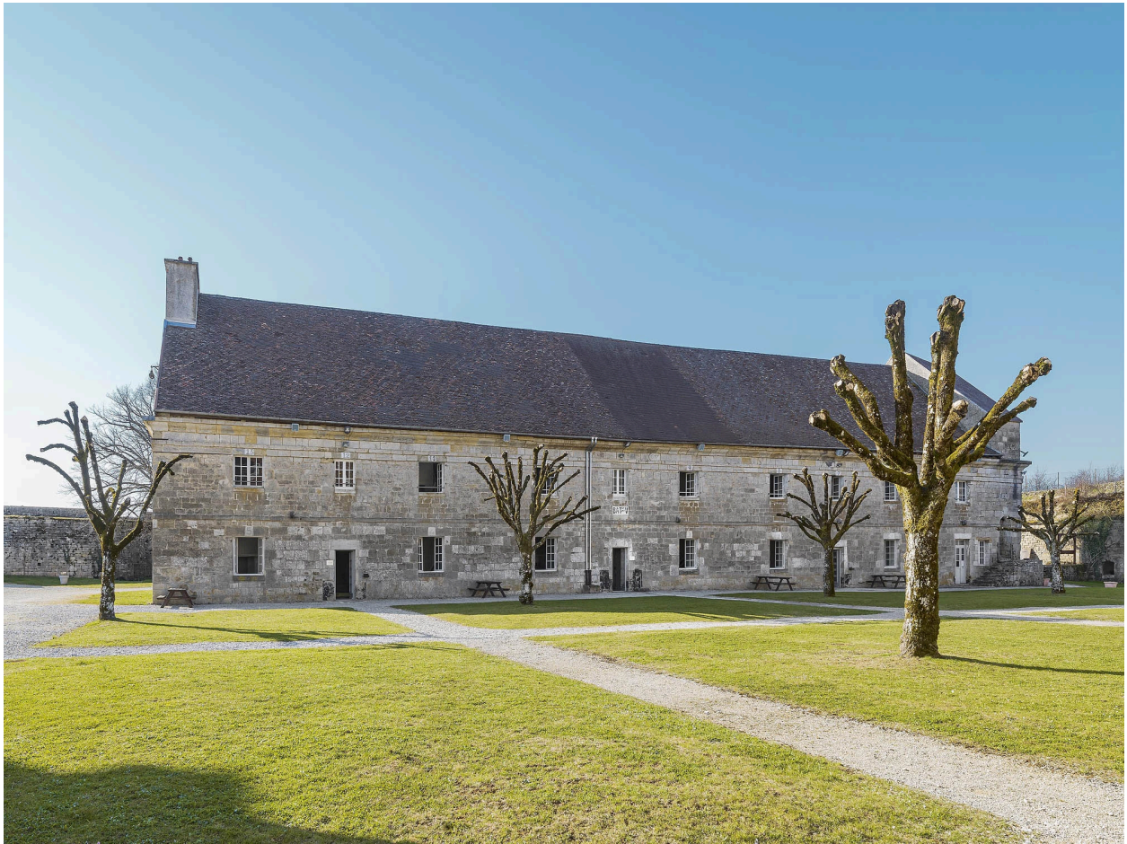
Caserne V : façade antérieure.
