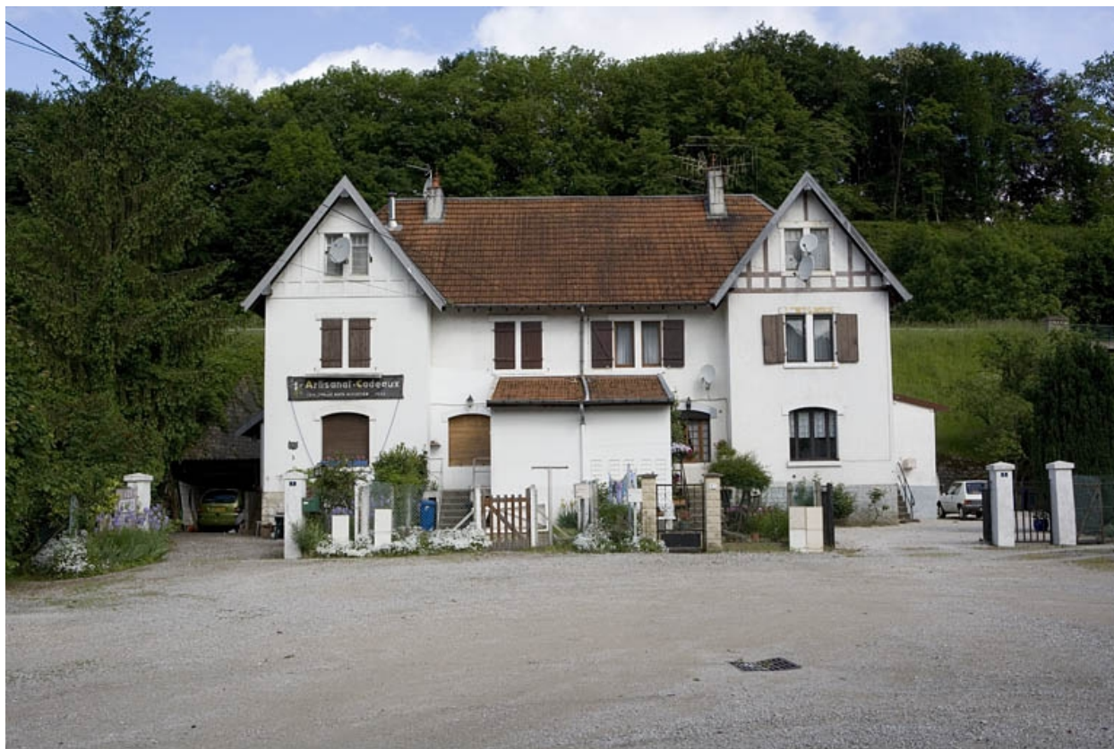
Logement d'ouvriers (3, 5 rue Weibel). Façade antérieure.
