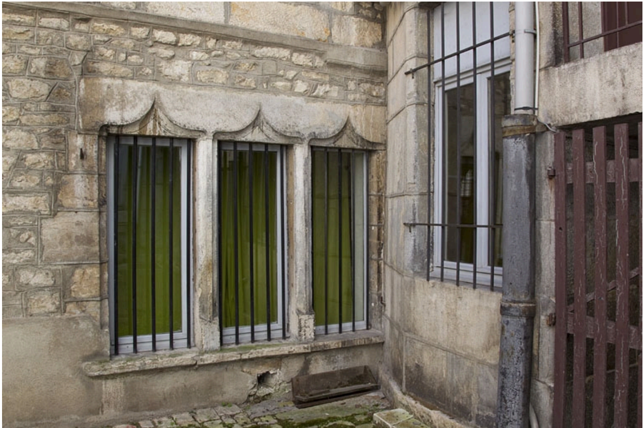
Façade antérieure du premier logis secondaire, rez-de-chaussée : détail des baies en accolade.
