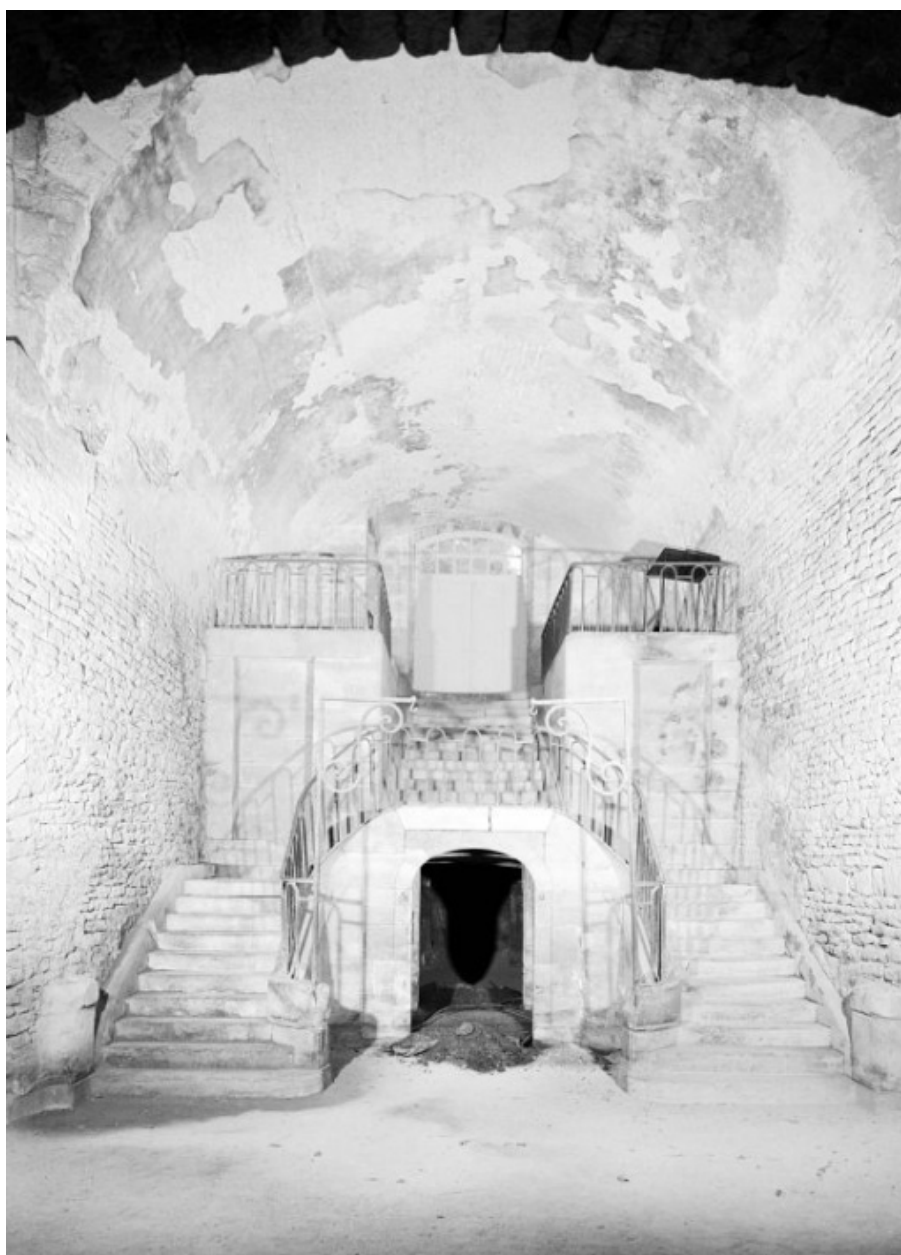
Haut fourneau, escalier d'honneur vu depuis la halle de coulée.
